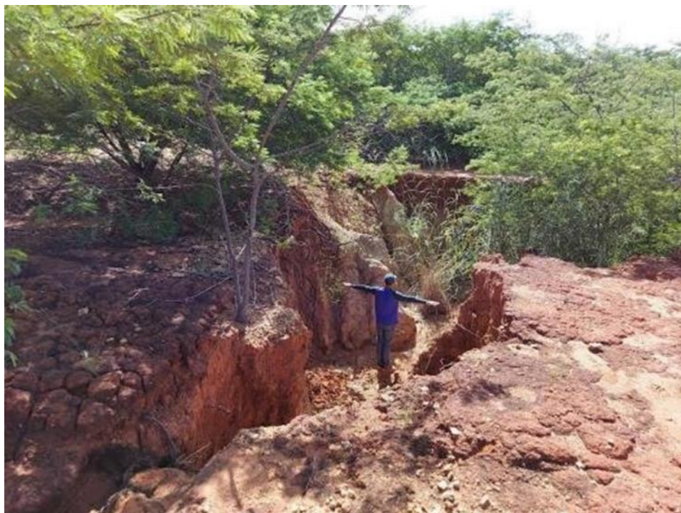
Figura 02 – Presença de voçoroca na localidade do Trussu, Iguatu. Fonte: Arquivo pessoal do autor (2022).
