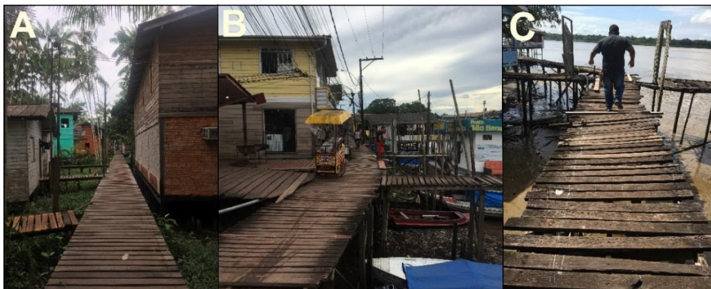
Figura 10 - Infraestrutura das moradias e passarelas. Fonte: Acervo das autoras, 2021.
