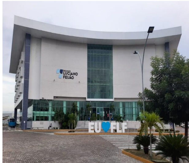
Foto 01 - Fachada da Faculdade Luciano Feijão. Fonte: Carneiro (2021).
