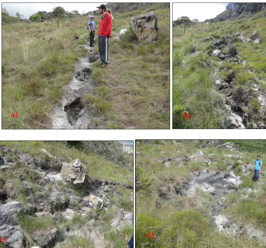
Figura 5 - Degradação da trilha pela conjugação de solapamento basal (erosão subsuperficial) e knick points (erosão superficial concentrada). A) aspectos de degradação ou desequilíbrio ambiental em período de déficit hídrico; B) transformação da trilha após período de altos índices pluviométricos; C) ponto de monitoramento perdido por processos erosivos; D) busca por caminho alternativo no trecho impactado. T Foto: A. C. Campos (2015).
