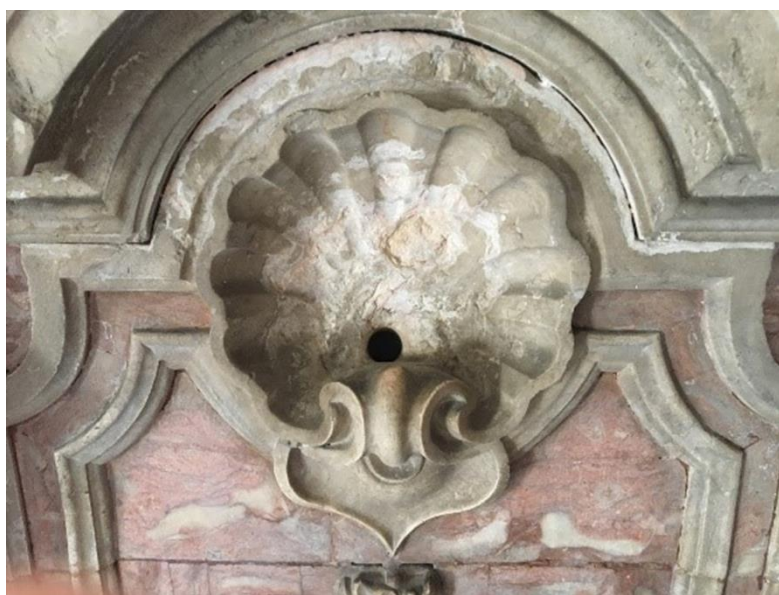
[Fig. 17] – Detalhe da entrada de água no lavatório da capela de Nossa Senhora da Glória, Rio de Janeiro. Fonte: Fotografia do autor.
