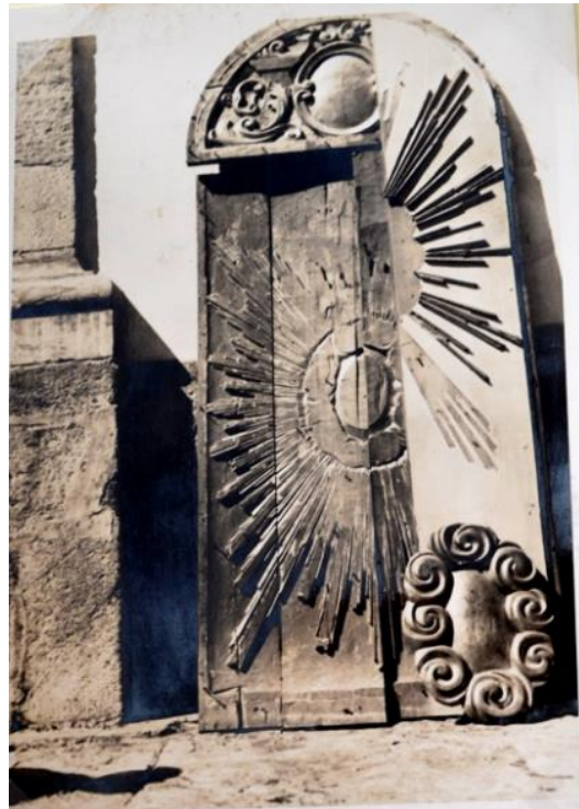
[Fig.6] Vista do fundo antigo encontrado do retábulo de N. Sra. da Boa Morte e do fundo colocado por cima deste. Fonte: XAVIER FILHO, Geraldo Francisco. Relatório das fotografias do altar de Nossa Senhora da Boa Morte da Catedral de Nossa Senhora do Pilar em São João del Rei/Minas Gerais . [ACI-RJ] / Série CRBC / Caixa s/número]. IPHAN. São João del-Rei, 1970.
