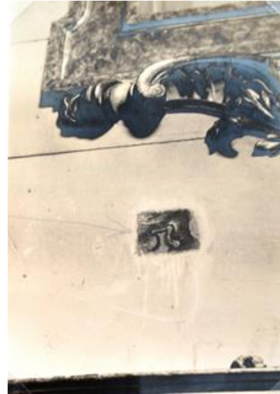
[Fig.10] Janela de prospecção e teste de remoção de pintura de cor branca sobreposta à decoração da parede lateral da capela-mor (revestida por painéis de madeira). Fonte: XAVIER FILHO, Geraldo Francisco. Relatório do trabalho de Restauração feito na Catedral de Nossa Senhora do Pilar em São João del Rei/Minas Gerais . [ACI-RJ] / Série CRBC / Caixa s/número]. IPHAN. São João del-Rei, 1971.
